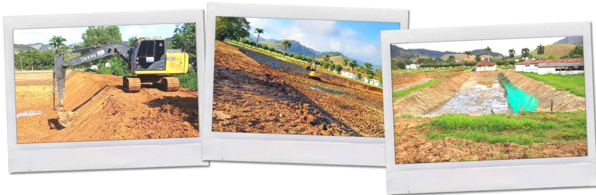
Reforma e manutenção de tanques escavados
