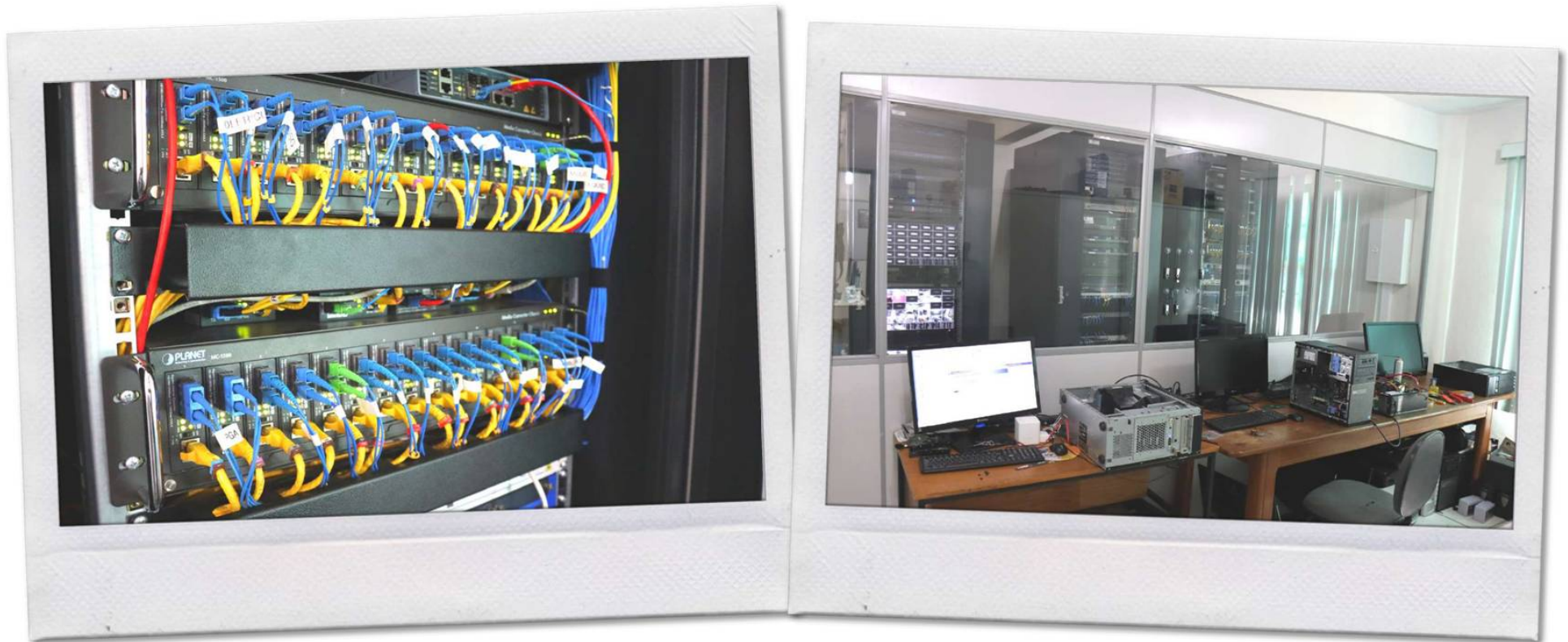
Implantação de cabeamento de fibra óptica
