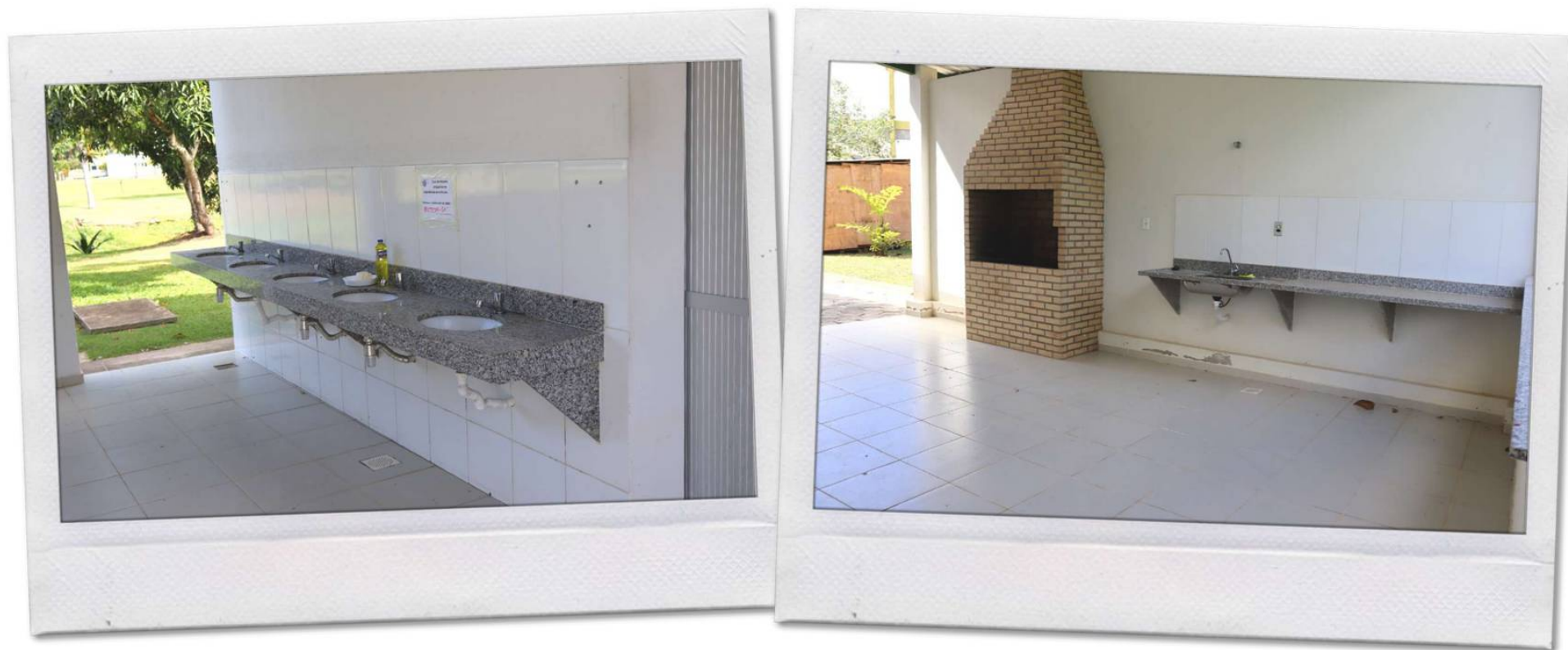
Reforma e adequação do Refeitório
