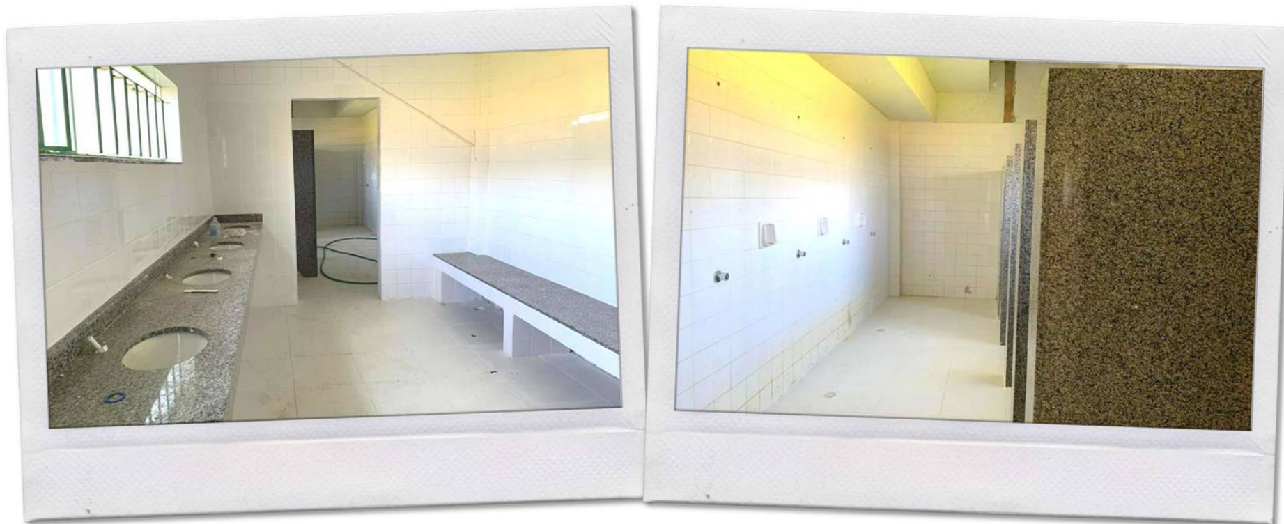
Reforma e adequação dos banheiros do Ginásio Poliesportivo (em andamento)
