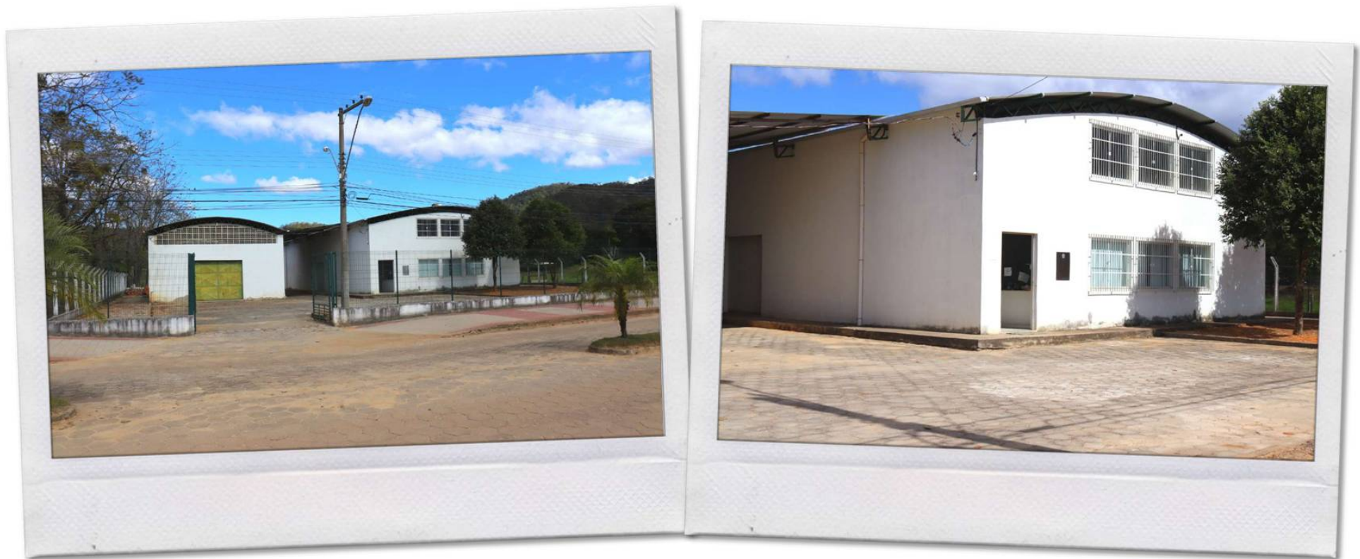
Construção do segundo prédio para Almojarifado, incluídos o cercamento e a pavimentação do entorno
