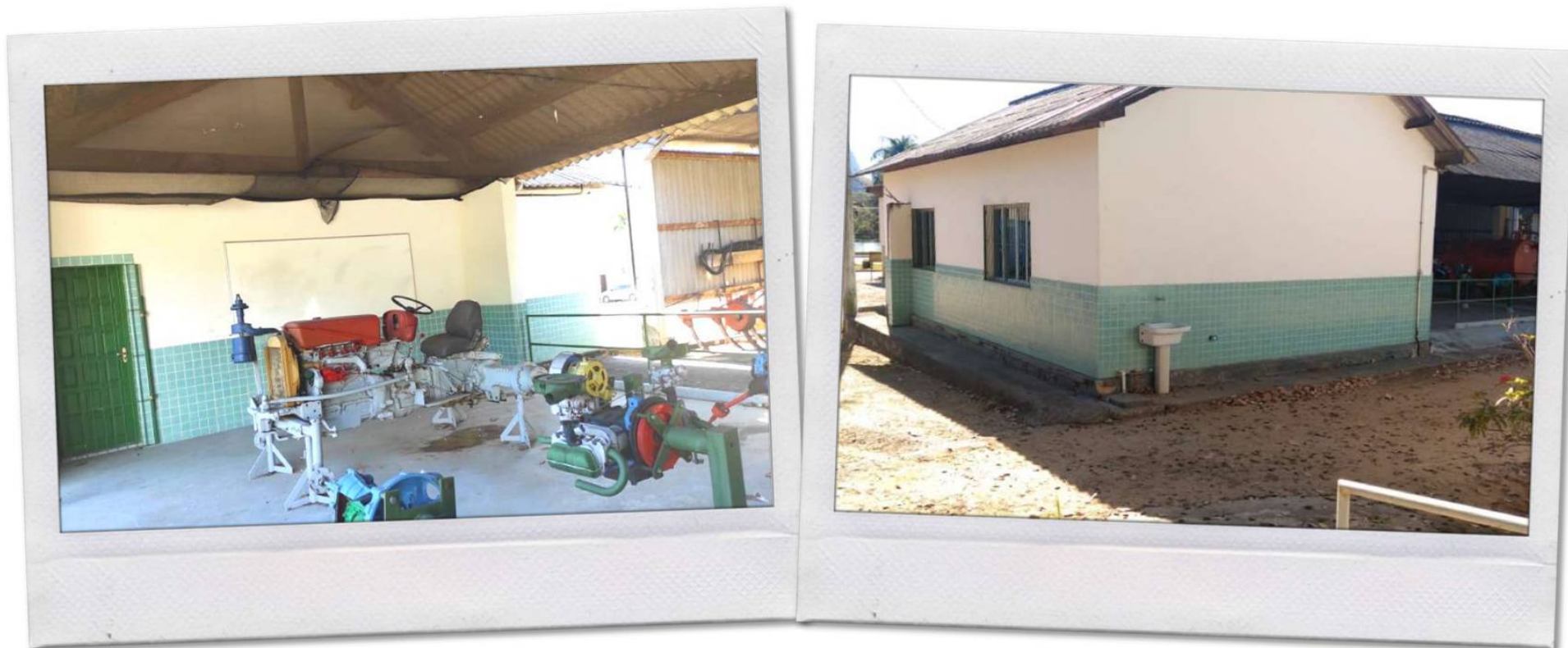
Reforma da sala de aula prática de Mecanização
