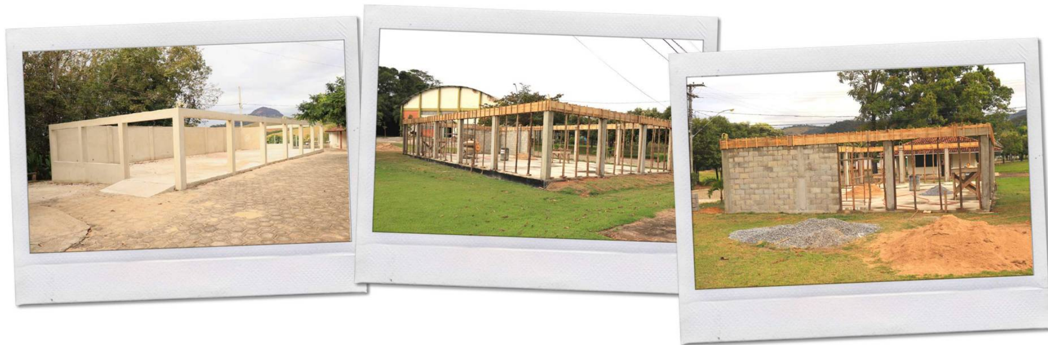
Construção de três áreas de vivência para os discentes (em andamento)
