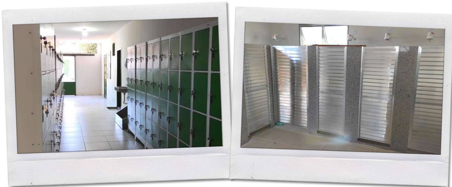
Reforma e adaptação dos banheiros da Unidade de Agroindústria
