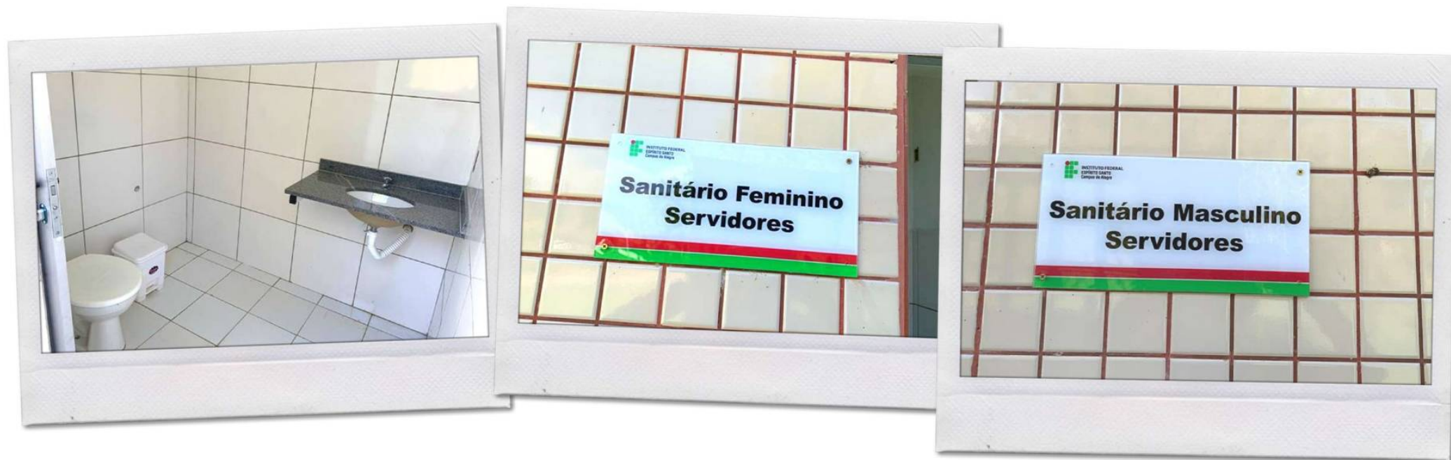
Construção de sanitário masculino e feminino para servidores no Prédio 2 (localizado em frente à Biblioteca)
