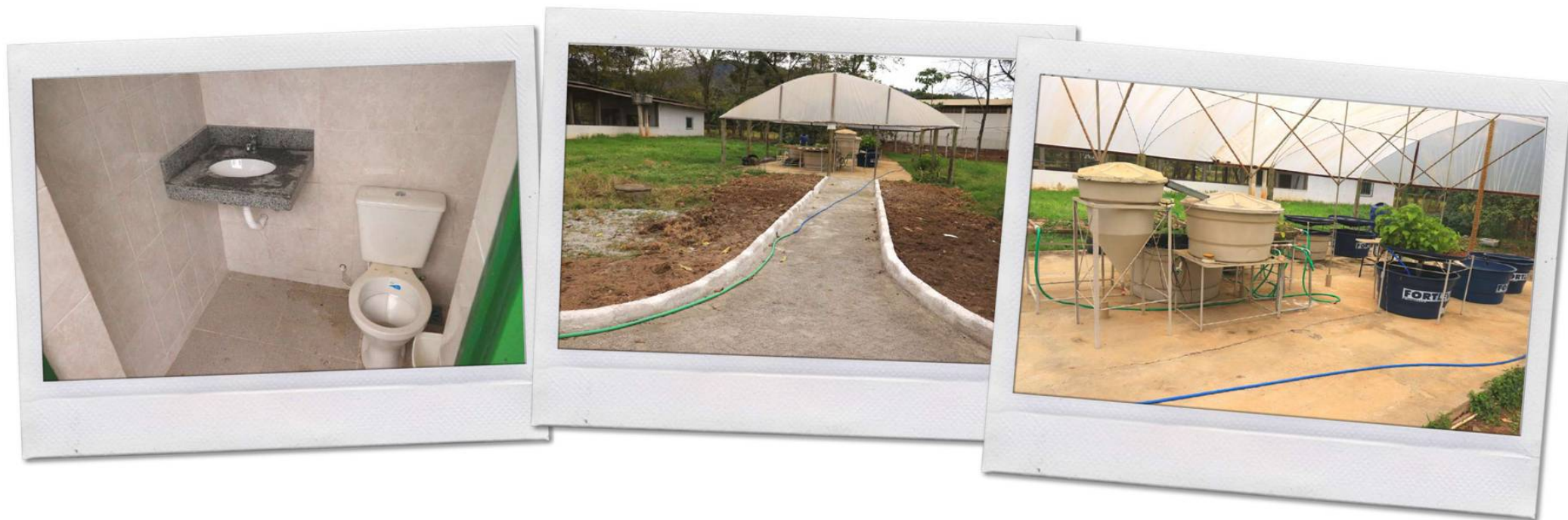
Reforma e adequação da sala de aula da Avicultura
